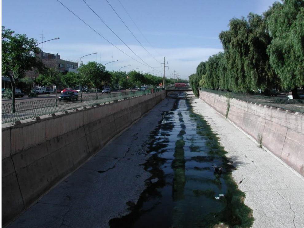
Figura Nº 9. Tramo donde se ve el Zanjón canalizado durante su paso por la ciudad de Mendoza. Foto propia.
