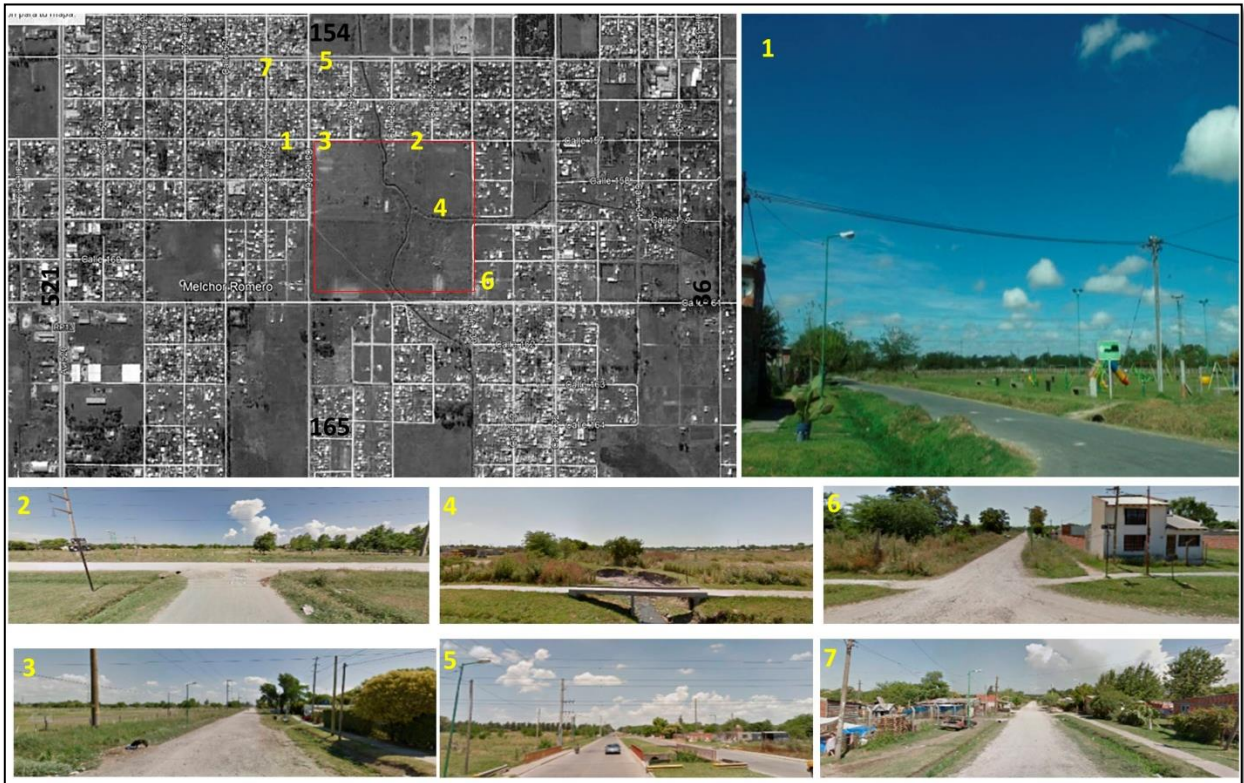
Fig.4: Ubicación y características de la zona del A1 (Elaboración propia en base a Google Earth 2017, Street View y Fotografías propias)
