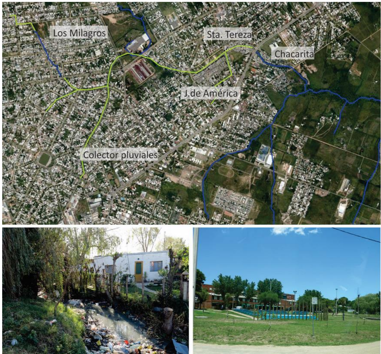
Fig. 1. Cañada de la Chacarita. Proceso de completamiento urbano con tramos entubados (amarillo) y a cielo abierto (azul) (imagen 2016). Asentamiento Los Milagros (nacientes), Cooperativa Juana de América (tramo medio, espacio público sobre arroyo entubado).
