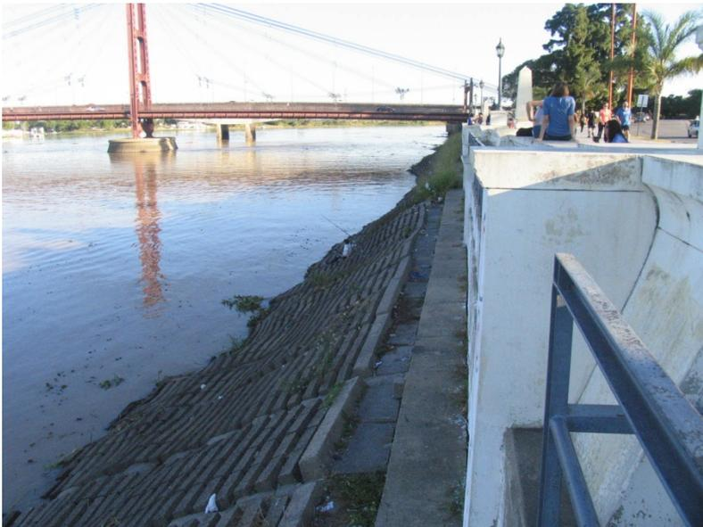
La estabilización de la Costanera Oeste por medio de bloques de hormigón y geotextiles para el control de la erosión. Al fondo en Puente Colgante reconstruido.
