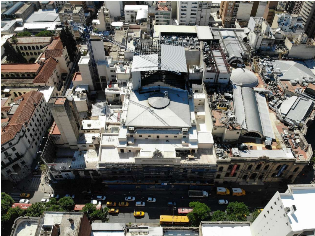
Figura N° 4. Imagen de dron tomada durante la intervención como parte del registro de obra. Puede verse sobre la caja escénica la grúa instalada para la puesta en obra de los materiales. En primer plano también se puede ver la fachada completamente cubierta por los andamios.
