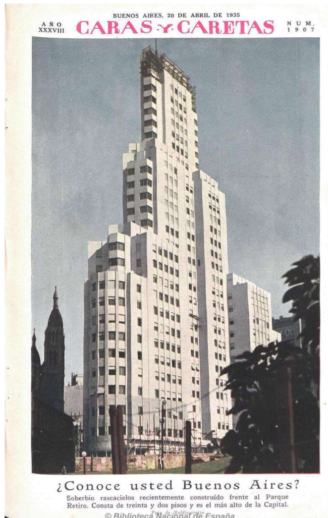
Fig.5. Sánchez, Lagos y de la Torre: el Edificio Kavanagh en construcción en la portada de Caras y Caretas, N°1907 Año XXXVIII, 20 de abril de 1935.
