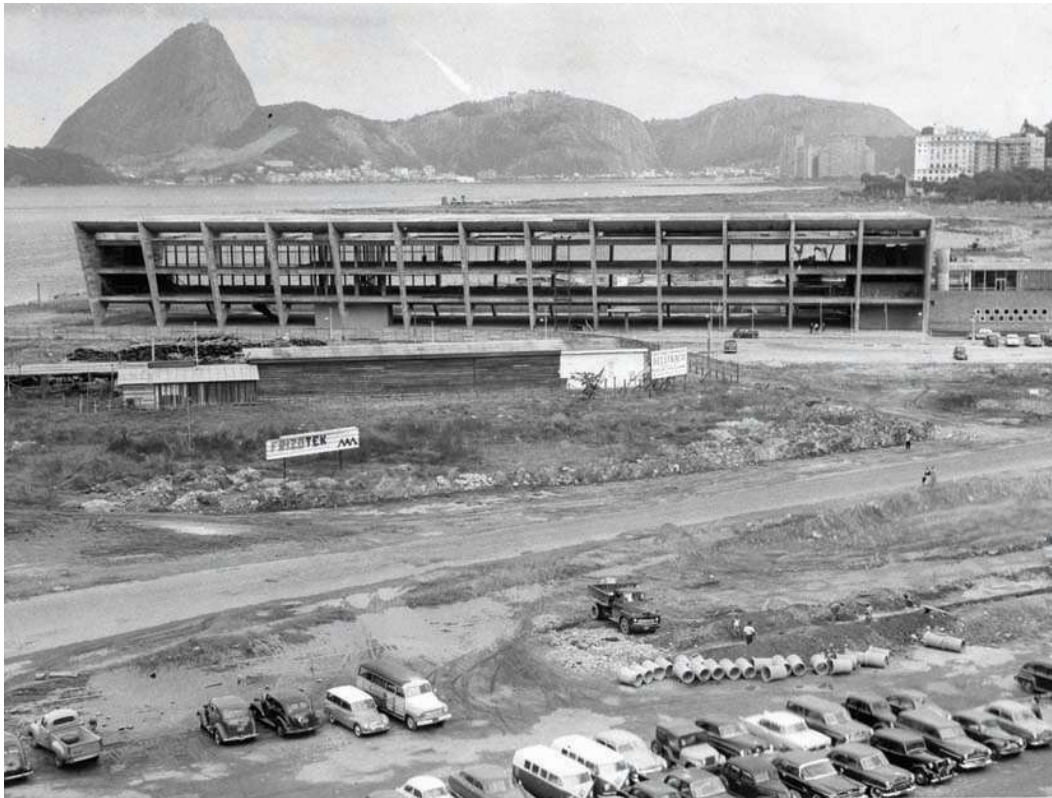
Figura 04. Vista de la estructura del bloque de exposiciones en construcción, c. 1960. Núcleo de Pesquisa e Documentação, FAU UFRJ.
