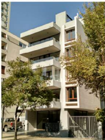
Figura N° 7: Obra nueva. Edificio residencial. Avenida Presidente Riesco, 2015
