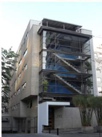
Figura N° 8: Obra nueva. Edificio residencial. Calle Carmencita, 2012
