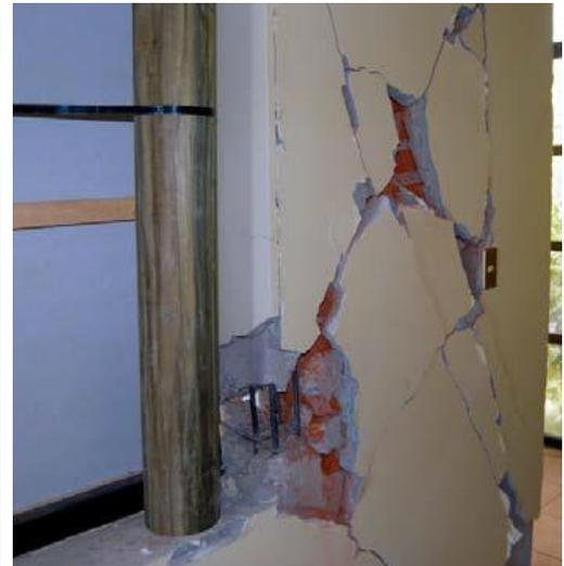
Fig.2 Daños en muros de albañilería confinada
