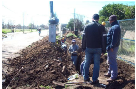
Fig. 10: Talud de excavación. OI
