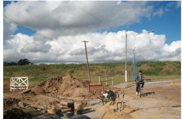
Fig. 14: Acopio de materiales. OI
